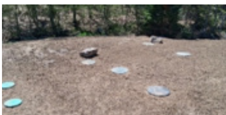
FOSSE SEPTIQUE - APRÈS TRAVAUX
