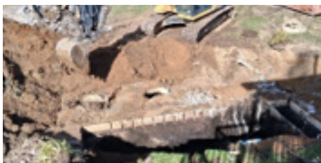
FOSSE SEPTIQUE - PENDANT TRAVAUX
